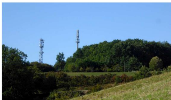
Panorama des pylônes du « Bois de la Chaise », vus depuis la route du Croix de l'Ormeau.
