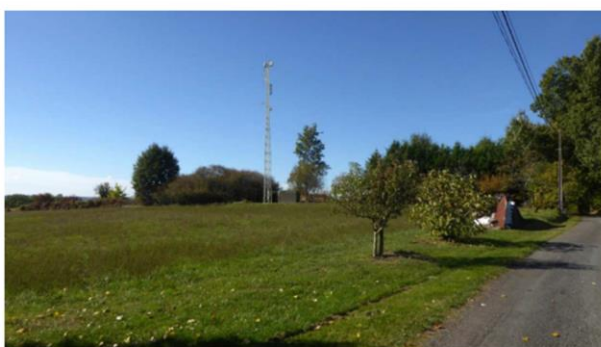
Vue du futur pylône towerCast, sur la parcelle F 307 de « La Chaise ».
